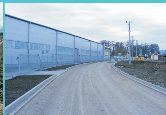
Budowa drogi gminnej w NOG
