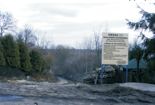
Budowa kanalizacji ul. Wesoła
