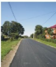
Od kilku tygodni trwa remont drogi. Były stawki: jedźdź nowa droga.
