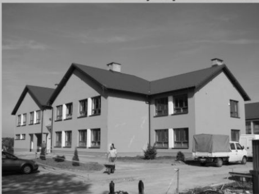
Ostatnie prace porządkowe
