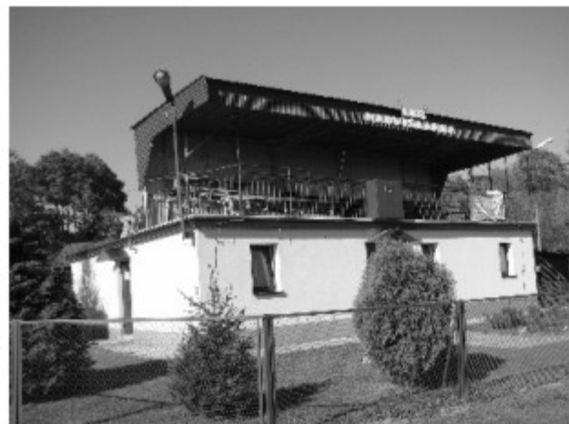
Odnowiony budynek klubowy
