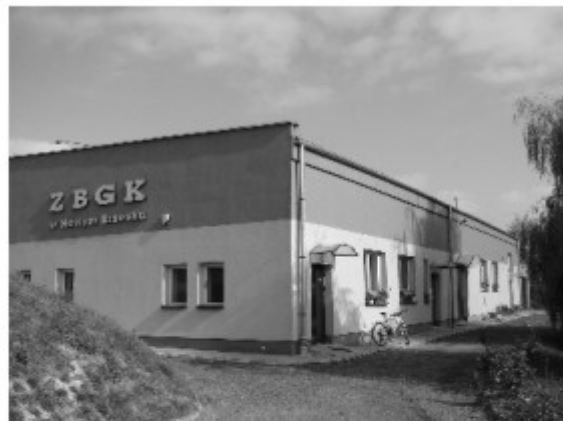
Wyremontowany budynek ZBGK
