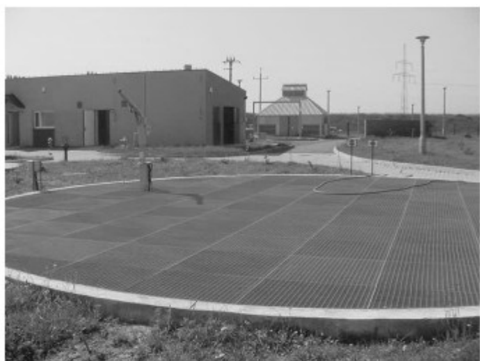
Oczyszczalnia ścieków w Nowym Brzesku
