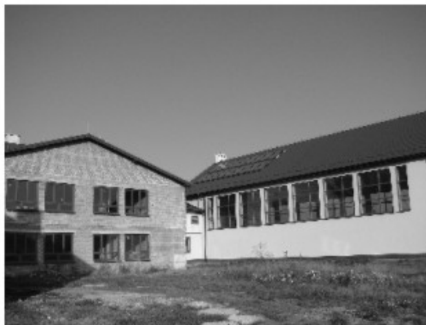
Szkola i sala gimnastyczna w Sierosławicach.
