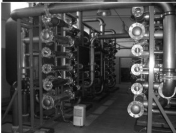
Budynek i urządzenia ZBGK
